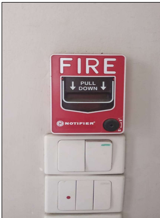
ภาพที่ 26 แสดงอุปกรณ์แจ้งเหตุเพลิงไหม้ (Fire)
